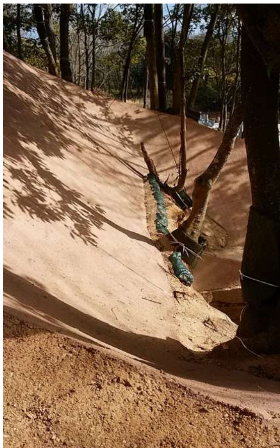
後円部石室 上部 土舗装
